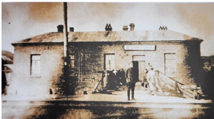
Железнодорожная станция «Вторая Речка». 1931 г. Фото В.К. Кипридова
