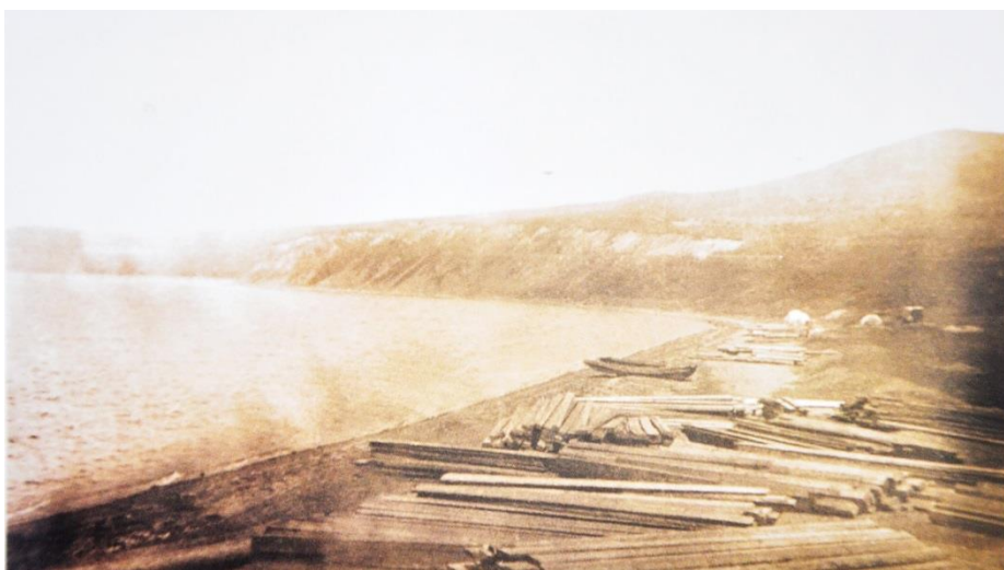
Начало строительства гидроаэродрома Вторая Речка (Мыс Фирсова). 1931 г. Фото В.К. Кипридова
