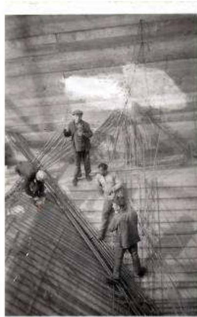
Бетонирование эстакады, предназначенной для заправки паровозов углем
