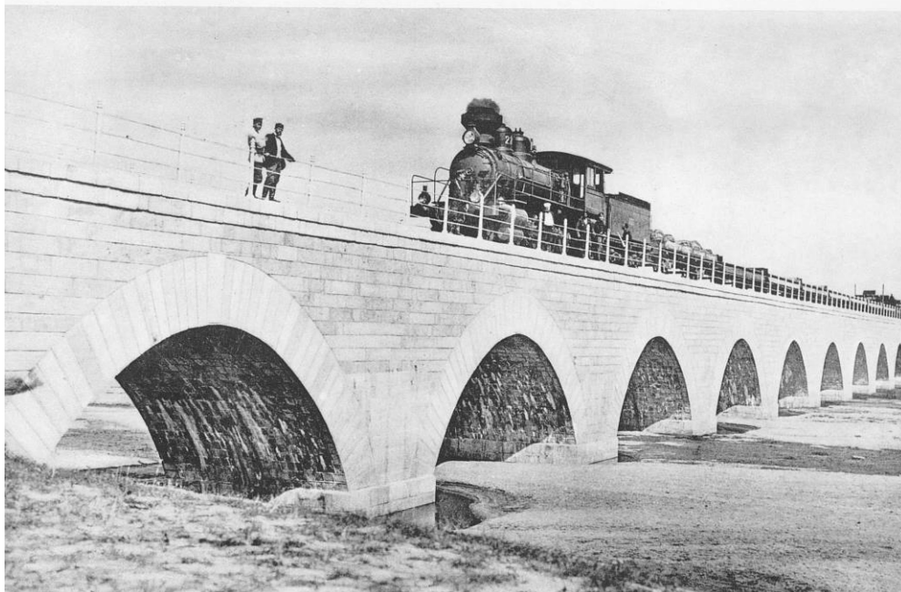
Рис 15. Мост на ЮМЖД через р. Пусихэ
