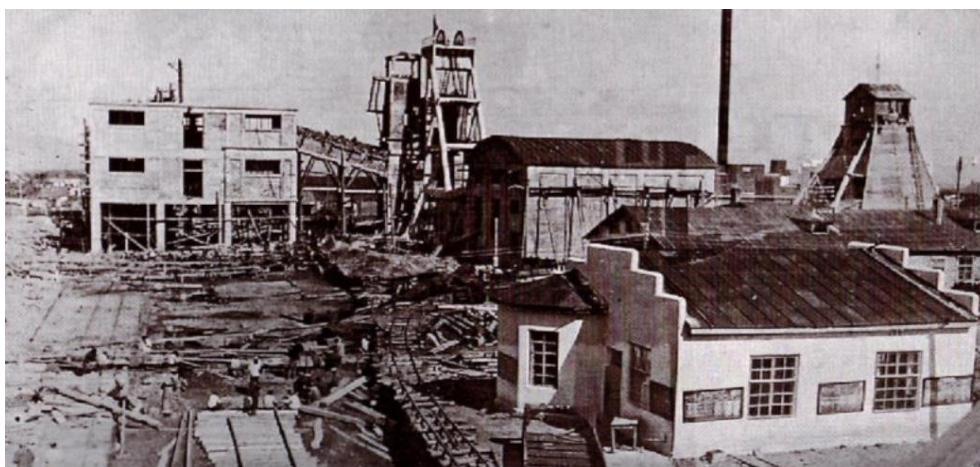
Строительство шахты 3-ц «Дальневосточная» . 1936 г. Фото из книги «Гори,шахтёрская звезда»
