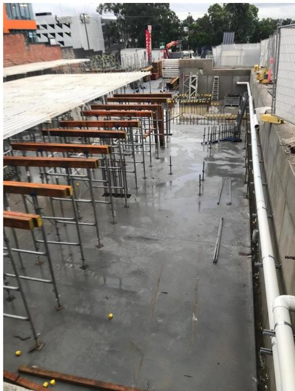
*Установка лесов для монолитного перекрытия пола первого этажа музея*
