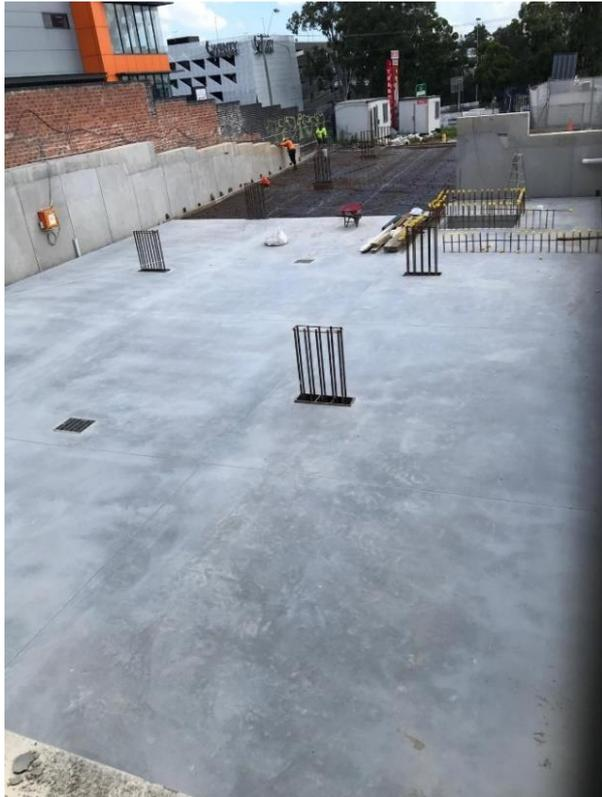
*Заливка бетоном арматурного каркаса пола подземной парковки*
